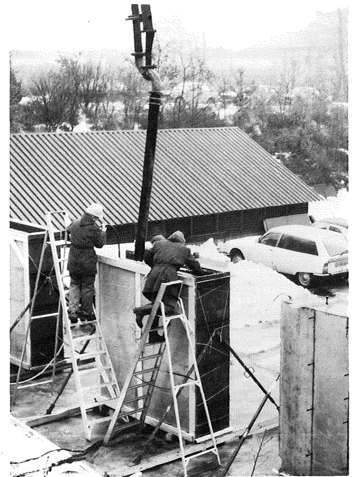
Støbning af forsøgsvejge med dimensionerne 0.45 x 2.4 x 2.4 m. Formpladerne er isoleret med mineraluldsmåtter. Ved varieret efterbehandling blev en serie vægge udsat for temperaturforskelle mellem midte og rand i området fra ca. 3 °C til ca. 34 °C. Billedet er fra vinteren 1978-79.
